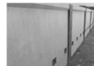
【HSYフィルター取付状況】 吸出防止材フィルター (HSYフィルター)▶P.25
